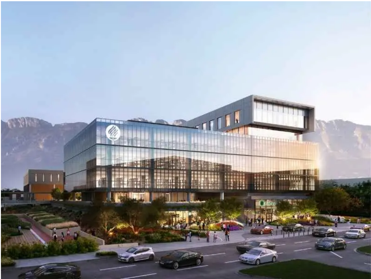
Imagen proyectada del Campus Ciencias de la Salud. Foto: TecSalud
