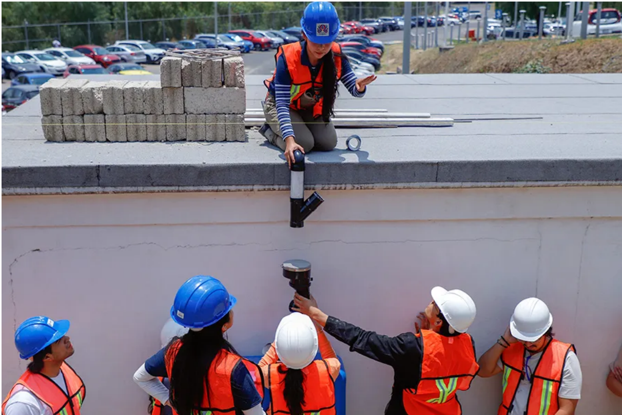
Estudiantes trabajando en la instalación del sistema de captación de agua de lluvia del Tec campus Estado de México. Foto: Aarón Muerza.
