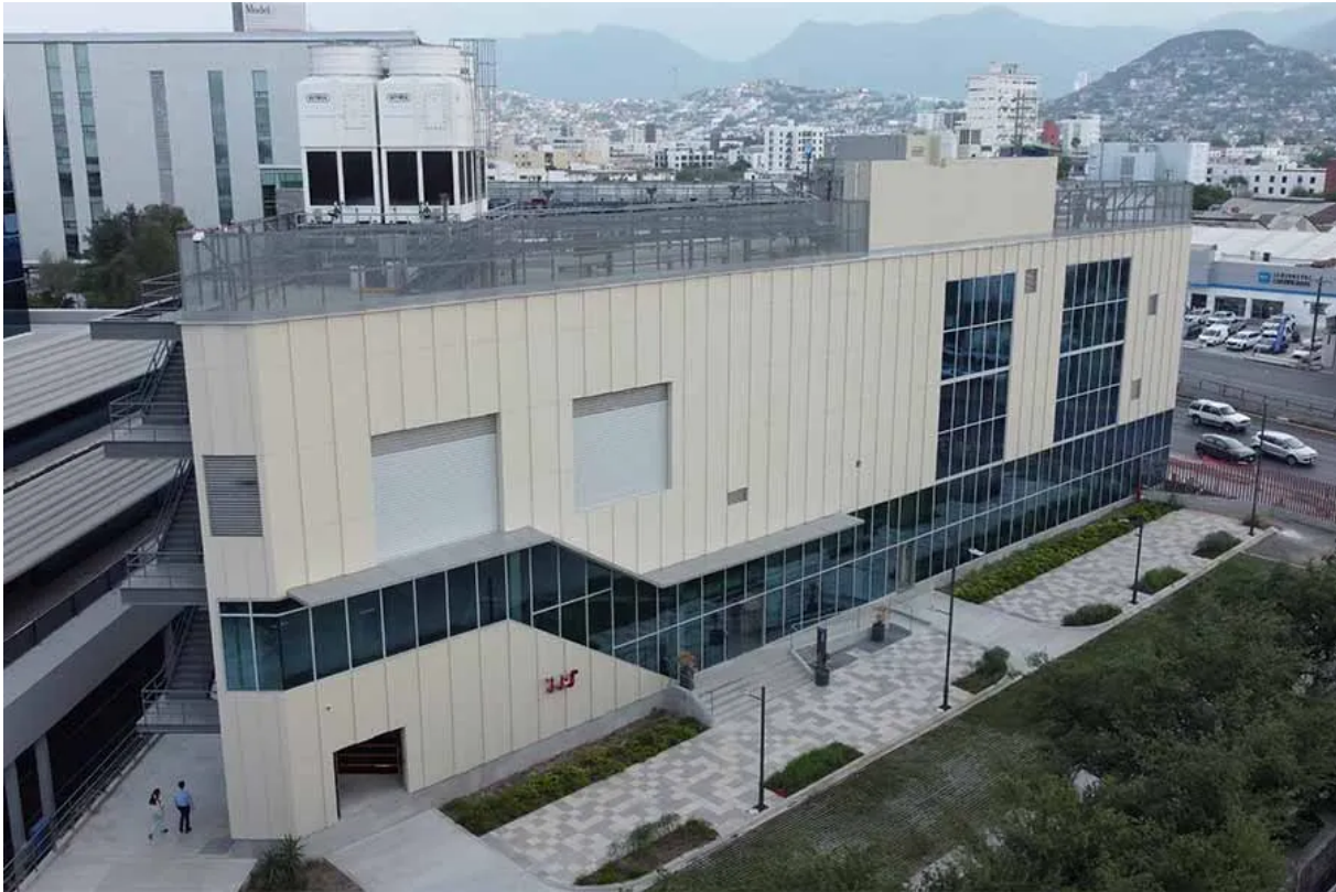
Núcleo es una Central Distrital que alberga diversos sistemas de generación energética. Foto: Jorge Valdés.
