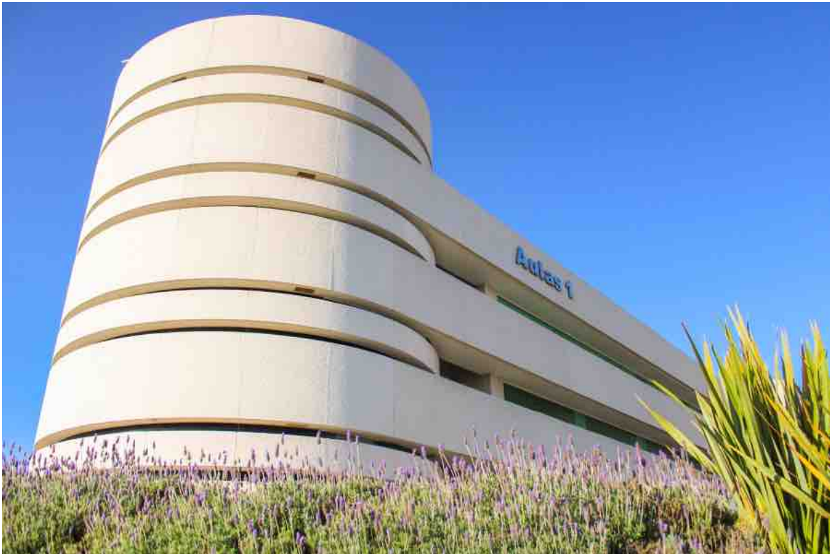
Renovación total para Aulas 1
